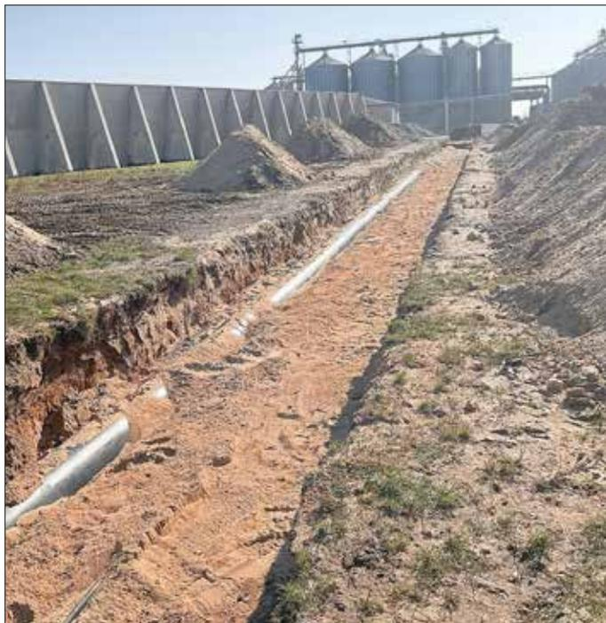
Baufortschritt in Quellendorf: Verlegung der Hauptleitung zur Heizzentrale Bild: GP JOULE
