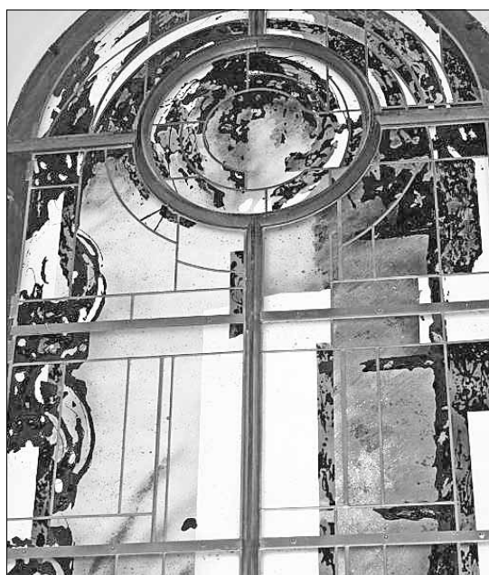
neu gestaltetes Südfenster
